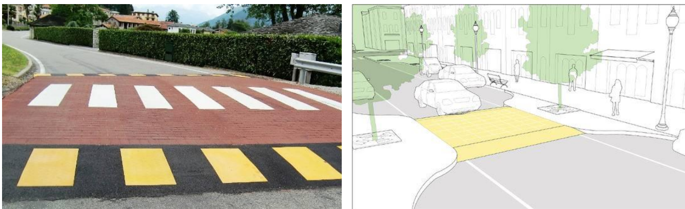
Figura 70 Attraversamenti pedonali rialzati
