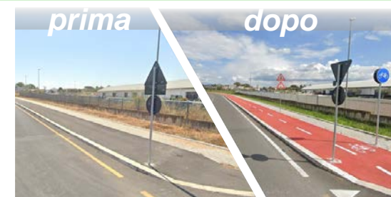
Pista ciclabile su corsia riservata su marciapiedi
